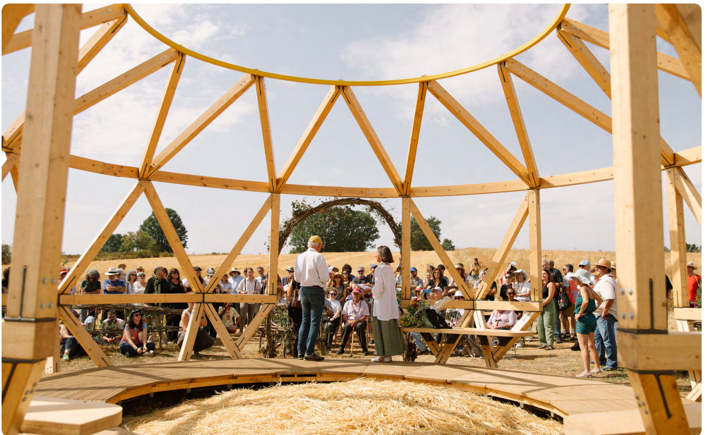
'Solaridades' obra resultante del proyecto Narrativas Solares. Foto: Raquel Santaolalla.
